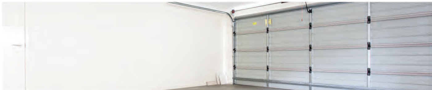
Riedmühlepark, Dietlikon, Allianz Immobilien, uszczelnienie garażu
