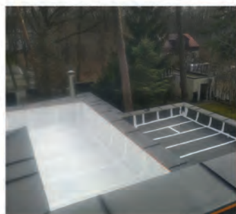
Po wymianie dachu
