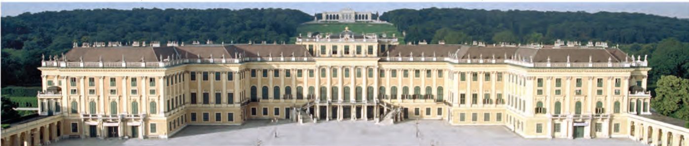
Hofer, Wiedeń – uszczelnienie piwnicy, 2017
