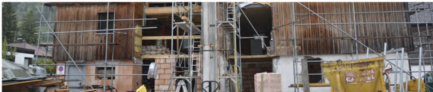
Architekt Dipl.-Ing. Flatz, Wolfurt – renowacja ściany zewnętrznej
