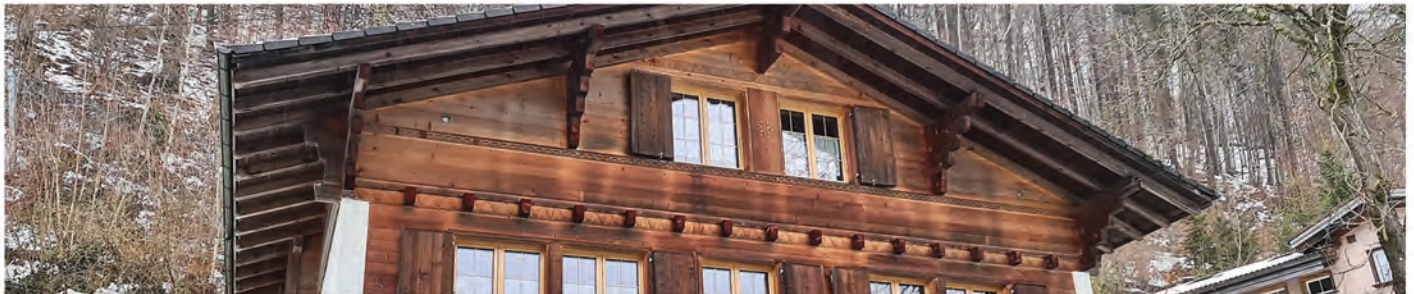
Kompletny remont, Schwandergässli, Brienz
