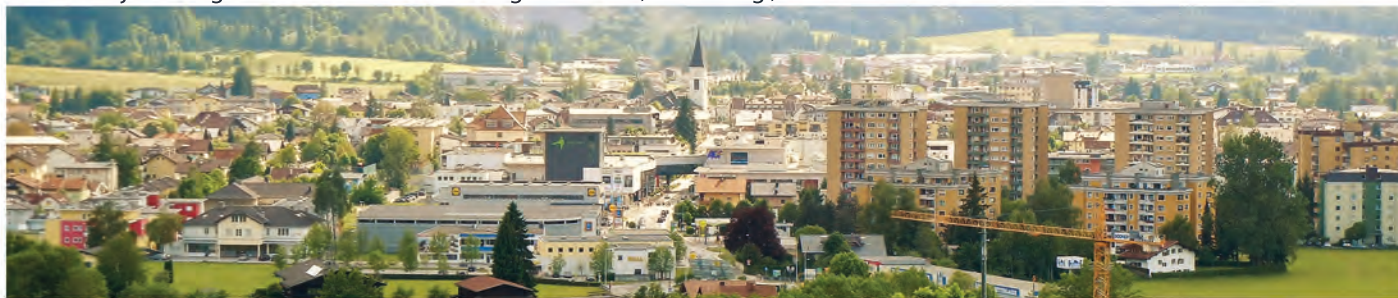
Spółdzielnia mieszkaniowa Gartensiedlung, 1140 Wiedeń – różne prace uszczelniające i renowacyjne od 2018 r.
