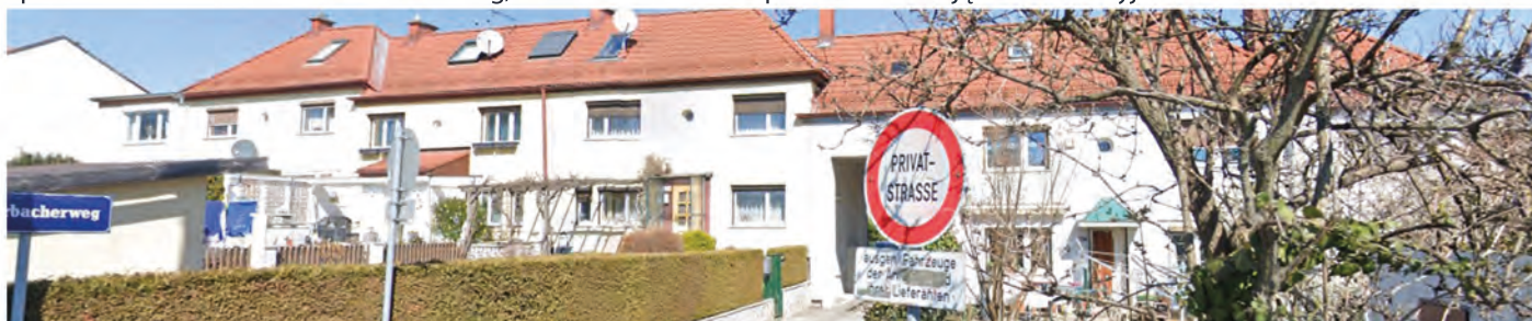
Centrum Edukacyjne Kenyongasse, 1070 Wiedeń – różne prace związane z osuszaniem murów, 2016 – obecnie
