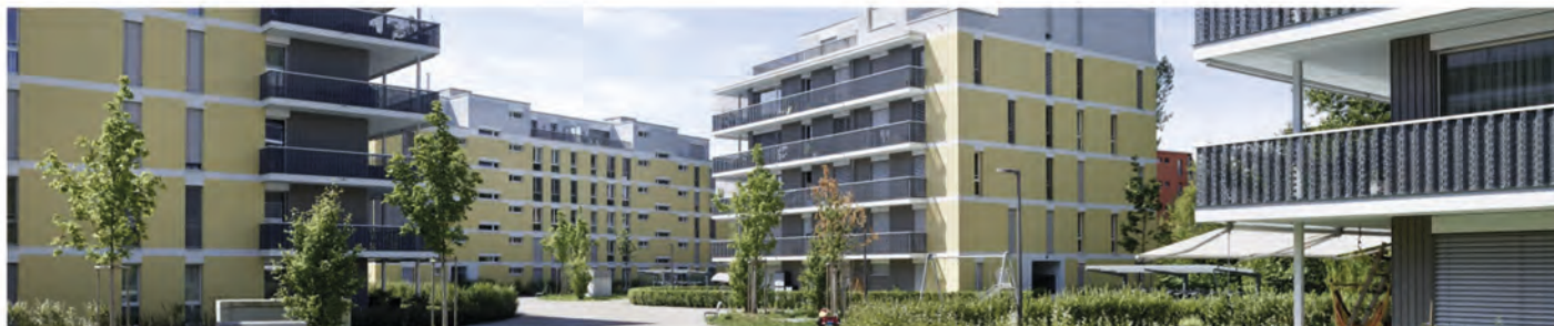
F & B Bau AG, Il瑙, uszczelnienie garażu
