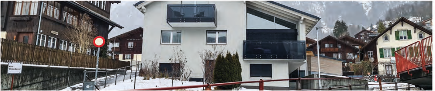
Kompletny remont, Trachtlistrasse, Brienz
