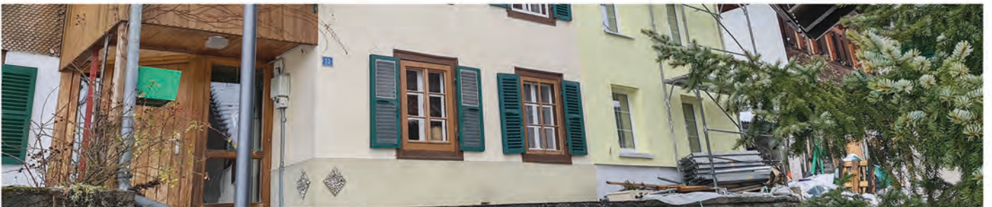
Budynek mieszkalny, garaż, nowa konstrukcja – późniejsze prace uszczelniające, Furttalstrasse, Zurych
